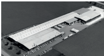
Montgomery, IL - Sectional Doors
